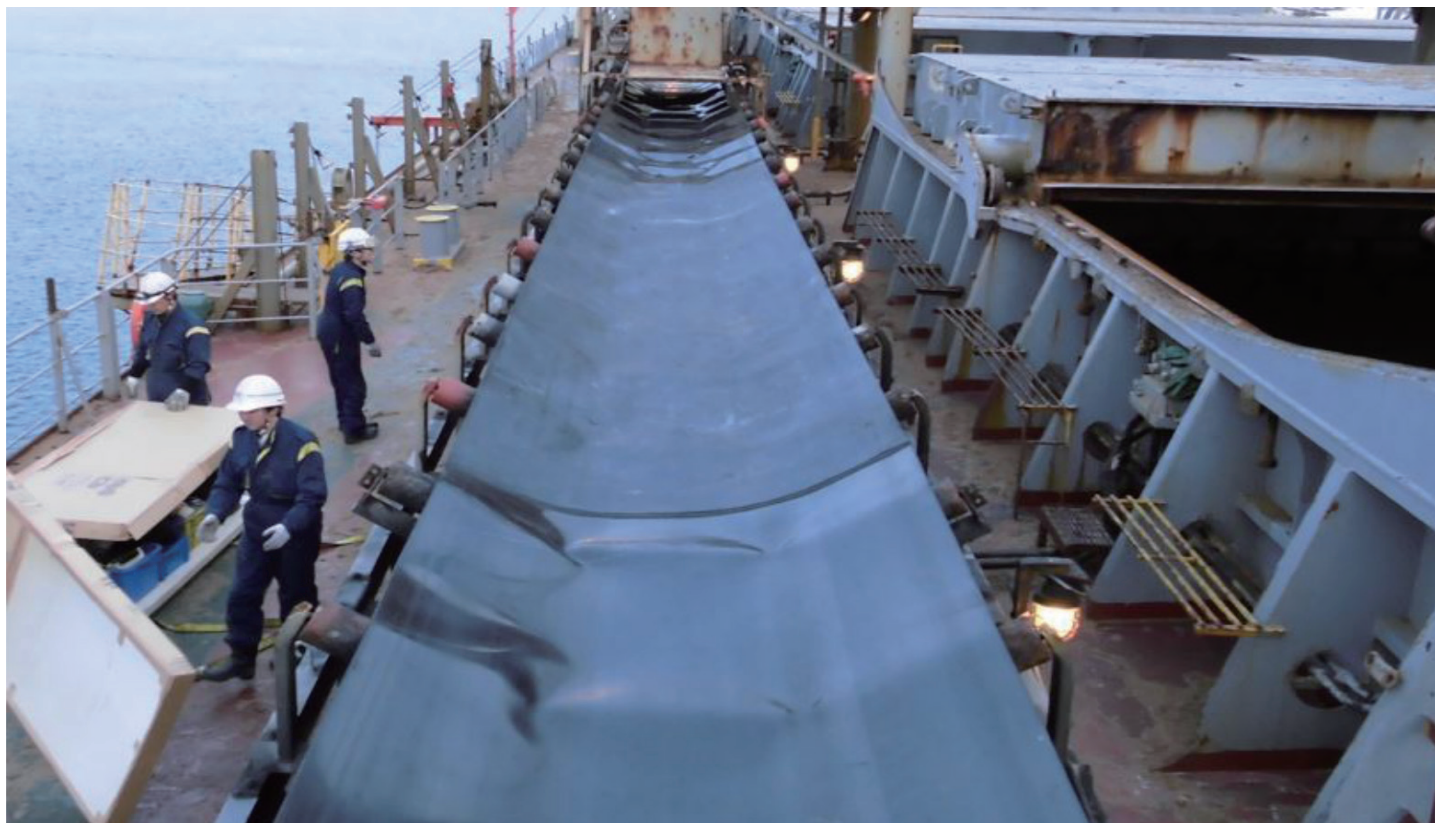
チップ船でのベルトエンドレス工事
